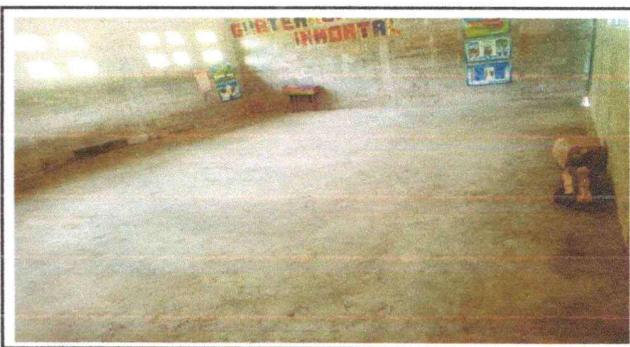
Foto 6: Piso entortada colocada en las aulas.
