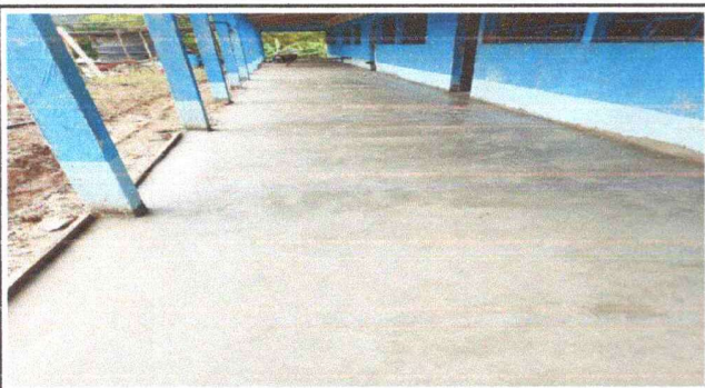
Foto 3: Piso en el corredor.
