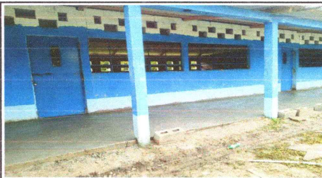
Foto 4: Colocacion de puertas
