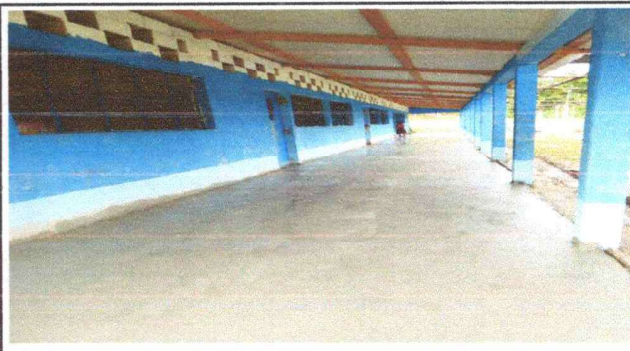
Foto 2: Piso ya colocada.
