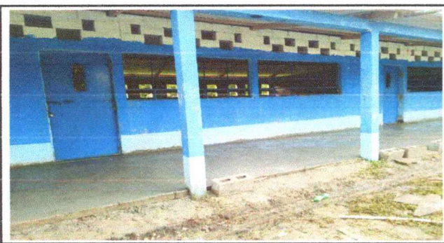
Foto 5: Colocacion de ventanas
