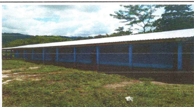
Foto1: Techo cambiado con lamina troquelada calibre 26.
